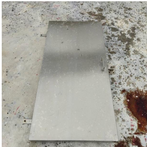
ภาพที่ 3.6.1 ถังเก็บน้ำชั้นตาดฟ้า อุบัติเหตุ-บริโภค แท็งก์ 1 ขนาด 77.2 ลบ.ม
