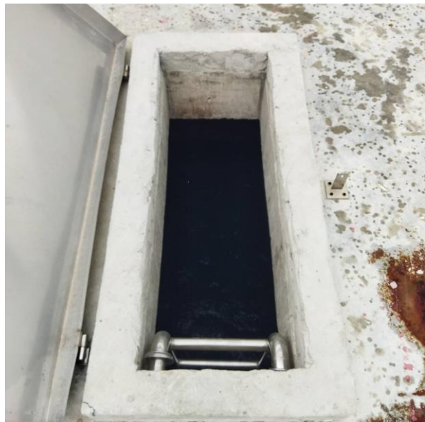
ภาพที่ 3.6.1 ถังเก็บน้ำชั้นตาดฟ้า อุบัติเหตุ-บริโภค แท็งก์ 1 ขนาด 77.2 ลบ.ม
