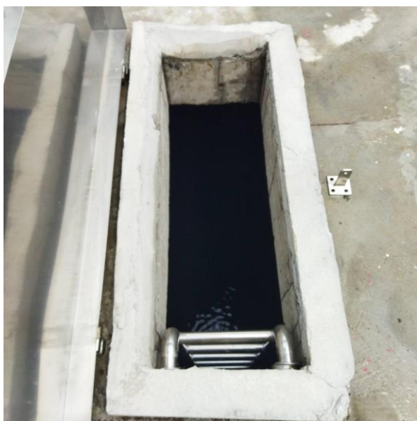
ภาพที่ 3.6.1 ถังเก็บน้ำชั้นตาดฟ้า อุบัติเหตุ-บริโภค แท็งก์ 1 ขนาด 77.2 ลบ.ม
