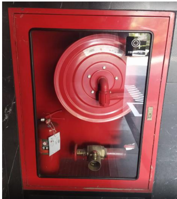
ภาพที่ 3.9.1 ติดตั้งตู้ดับเพลิงเห็นชัดเจนตามชั้น
