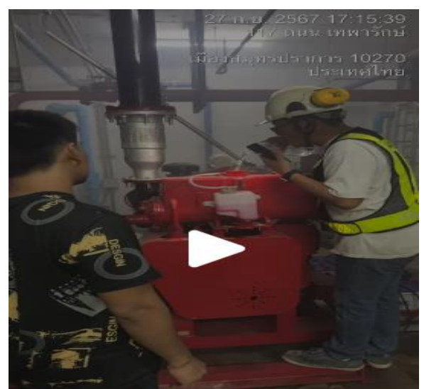
ภาพที่ 10.1 งาน PM ระบบส่งน้ำดับเพลิงประจำสัปดาห์และประจำปี
