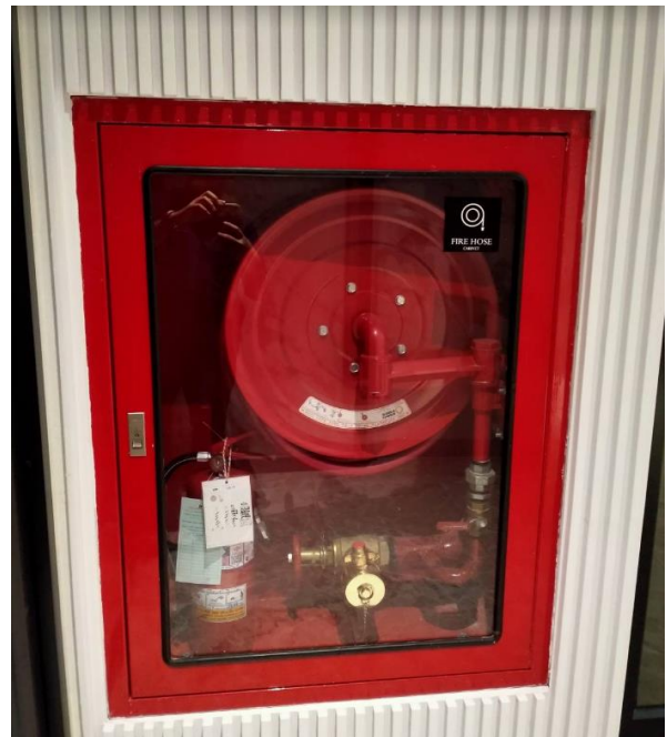
ภาพที่ 3.9.1 ติดตั้งตู้ดับเพลิงเห็นชัดเจนตามชั้น
