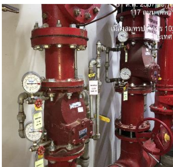
ภาพที่ 10.1 งาน PM ระบบส่งน้ำดับเพลิงประจำสัปดาห์และประจำปี
